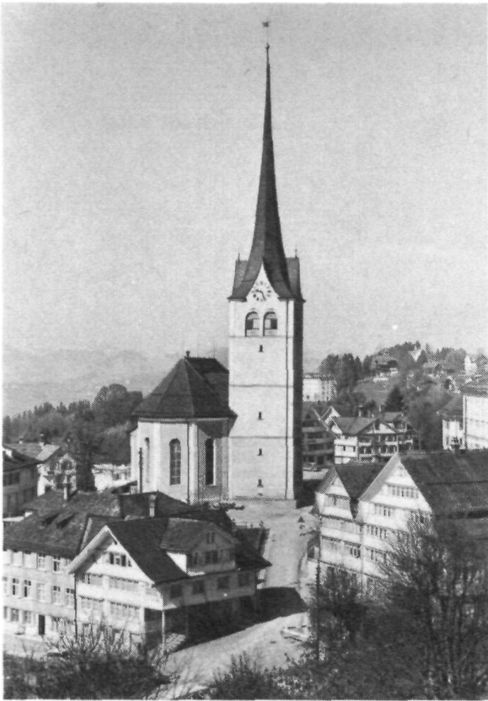
Abb. 28. Teufen. Reformierte Kirche, 1776 bis 1779, von Hans Ulrich Grubenmann. Blick auf die Ostpartie des dreiseitig geschlossenen Chors und des massigen Turms mit dem eleganten Spitzhelm.
