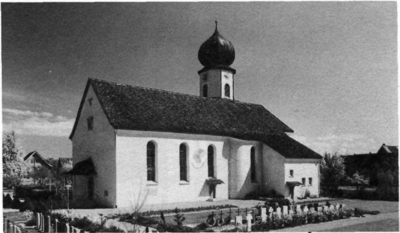
Abb. 22 Steinach. Katholische Kirche, Neubau 1742/43, von Jakob Grubenmann. Ansicht von Süd- westen.
