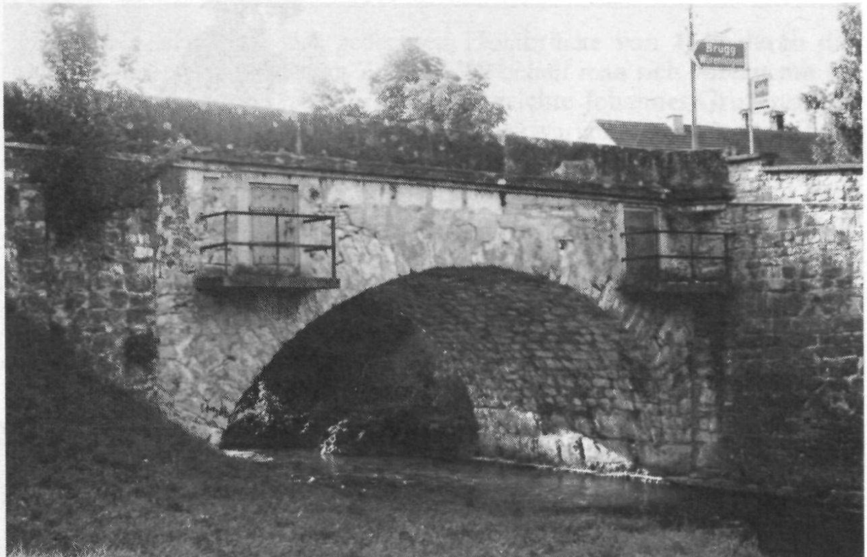
Ostansicht der Strassenbrücke in Tegerfelden, heutiger Zustand.
