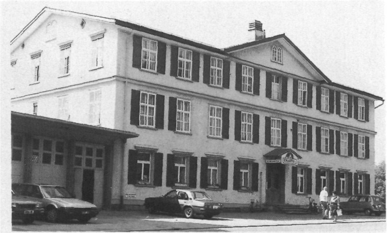
Das geschindelte Stickereigebäude Tobler dient heute unter anderem einer Feinschmeckerkochschule.
