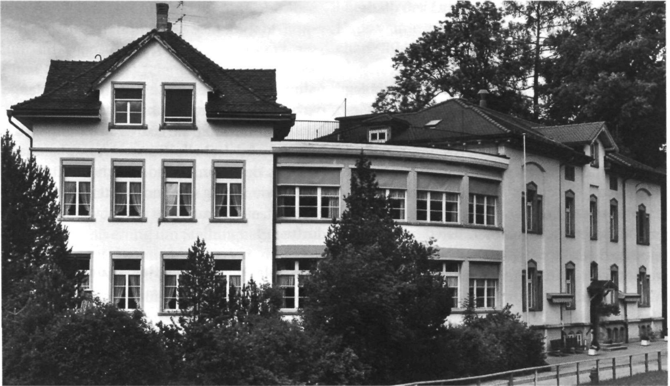
Immer wieder war in den letzten Jahresberichten der regionalen Pflegeheime Heiden und Trogen die Ablösung des früheren Krankenhauses in Trogen ein Thema. Ein Neubau aber ist noch nicht in Sicht, sodass das seit Jahren als Pflegeheim dienende, von Heiden aus verwaltete Haus seine heutige Aufgabe weiter zu erfüllen hat. (Bild: P. Eggenberger)
