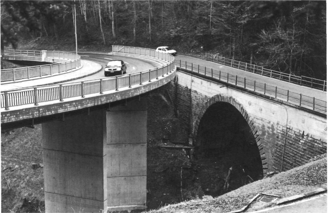
Am 23. September wurde die neue Brücke in der Bruggmühle (Strasse Heiden–Rheineck) eingeweiht. Das Bild zweier Brücken hat Seltenheitswert, ist doch der alte Übergang dem Abbruch geweiht. (Bild: P. Eggenberger)
