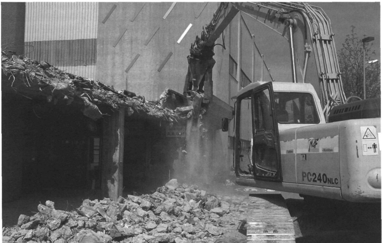
Die Genossenschaft Sportzentrum Herisau musste aus wirtschaftlichen Gründen an die Gemeinde verkaufen. Im Anschluss daran wurde saniert und erweitert.
