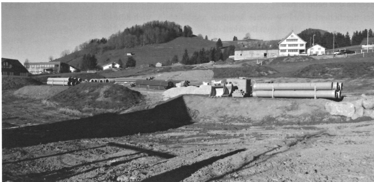
Überbauung der Liegenschaft Schönenbüel-Lehn.
