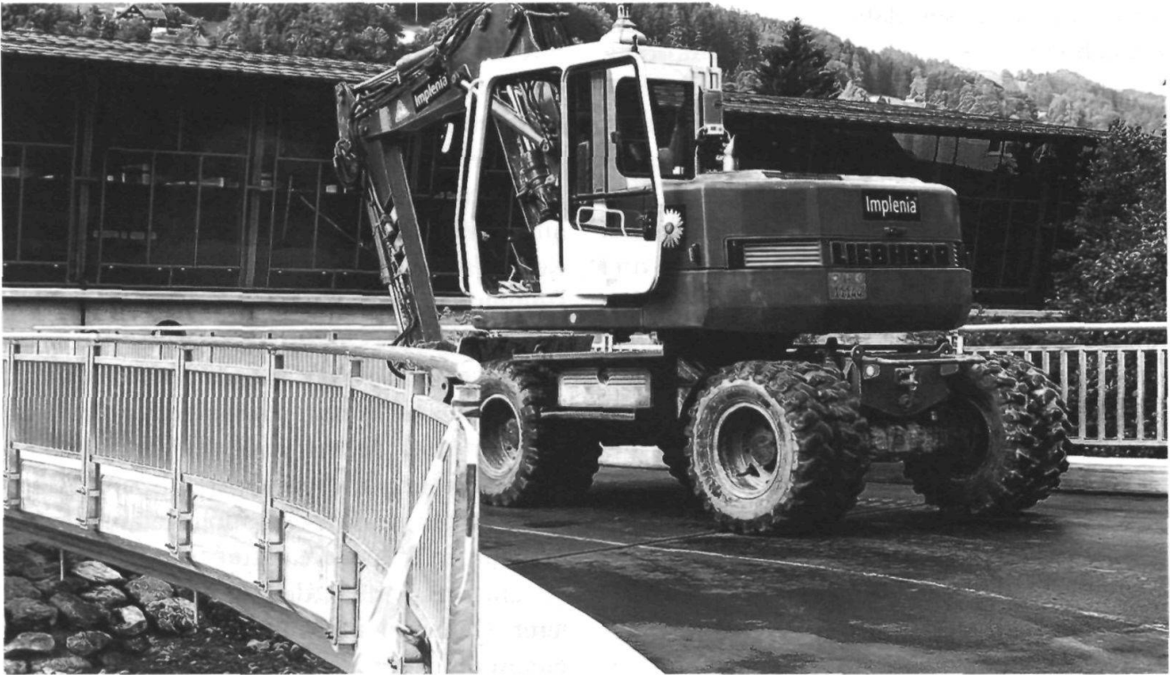
Die Brücke über den Rotbach, mit deren Bau einiges Ungemach verbunden gewesen war, konnte im Juni dem Verkehr übergeben werden. (Bild: Martin Kradolfer)
