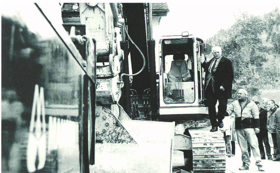
Landammann Jakob Brunnschweiler beim Spatenstich zum Beginn der umfassenden Erneuerung des Psychiatrischen Zentrums.
