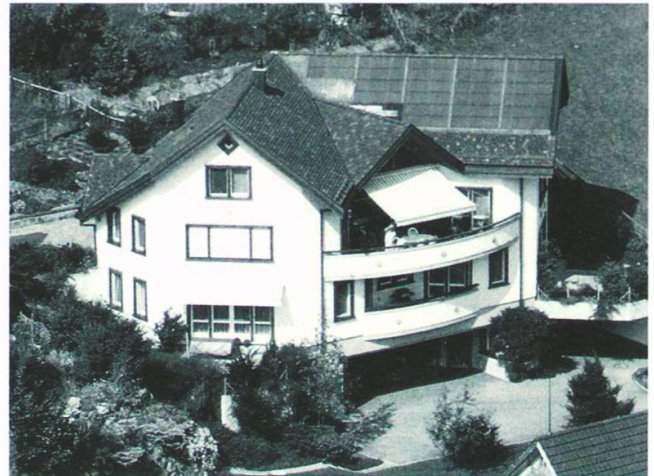
Das Paula-Koller-Haus an der Langgasse dient neu als Wohnsitz für Seniorinnen und Senioren.
