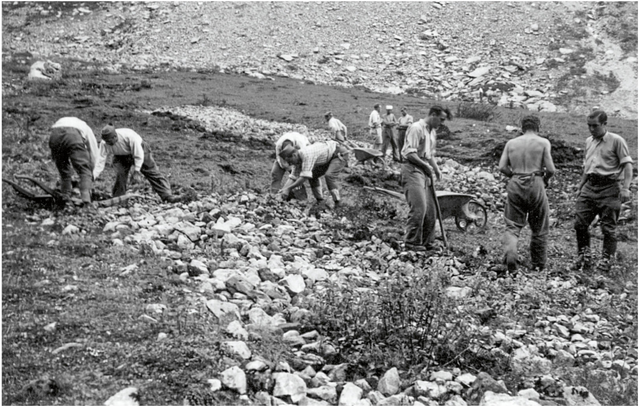
Steinräumung durch internierte Franzosen auf der Seealp (AI), Herbst 1940. Die Steine wurden zum Auffüllen von Mulden verwendet und mit Humus überdeckt.
