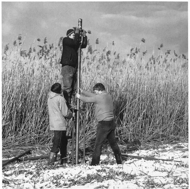
Abb. 16: Ins-Reservat Witzwil 1986. Bohrsondierungen im Schilfgürtel des Naturschutzgebietes Fanel.
