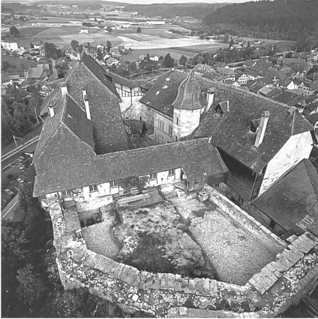
Abb.103: Laupen, Schloss. Die Gesamtaufnahme von Osten zeigt die elliptische Grundform der von dicken Ringmauern geschützten Hauptburg. Im Vordergrund die Ostbastion während der Grabung 1983.
