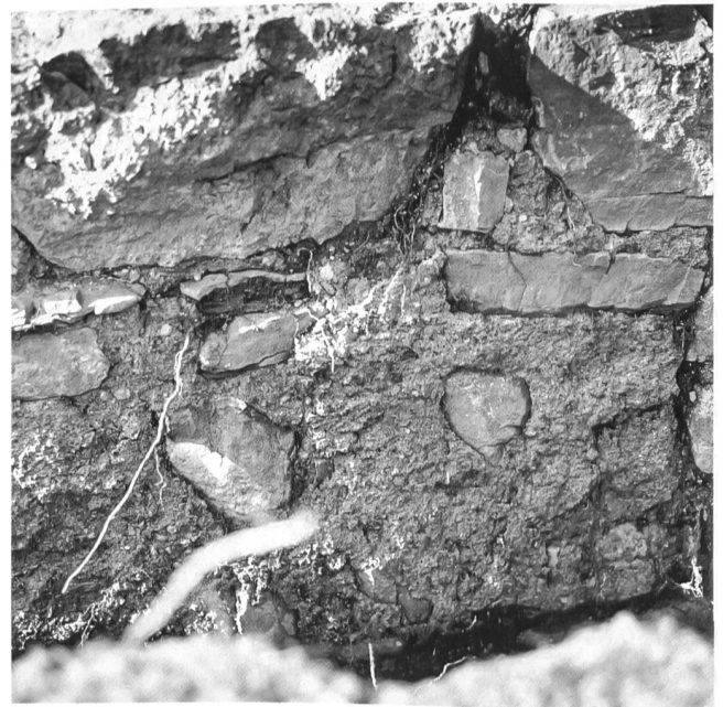
Abb.98: Därstetten, Ruine Weissenburg. Originaler Verputz am Donjon.
