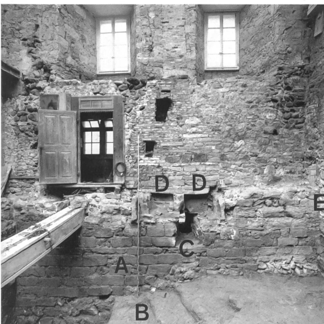
Abb.105: Laupen, Schloss. Südliche Wehrmauer (A) nach Abbruch der ehemaligen Pfistererei. Blick nach Süden in den einstigen Binnengraben (B). Im Sandsteinmauerwerk ist ein Fensterschlitz (C) erkennbar, darüber neuere Einbauten von Backöfen (D), rechts der Anstoss des Palas (E).
