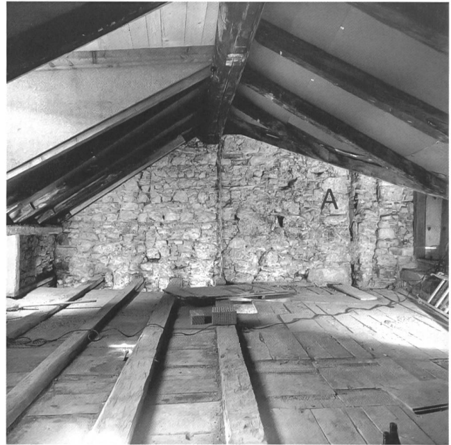
Abb. 88: Biel, Obergasse 16. Blick von Osten an den im Obergeschoss sichtbaren Wohnturm (Obergasse 14) mit Eckquadrierung (A).
