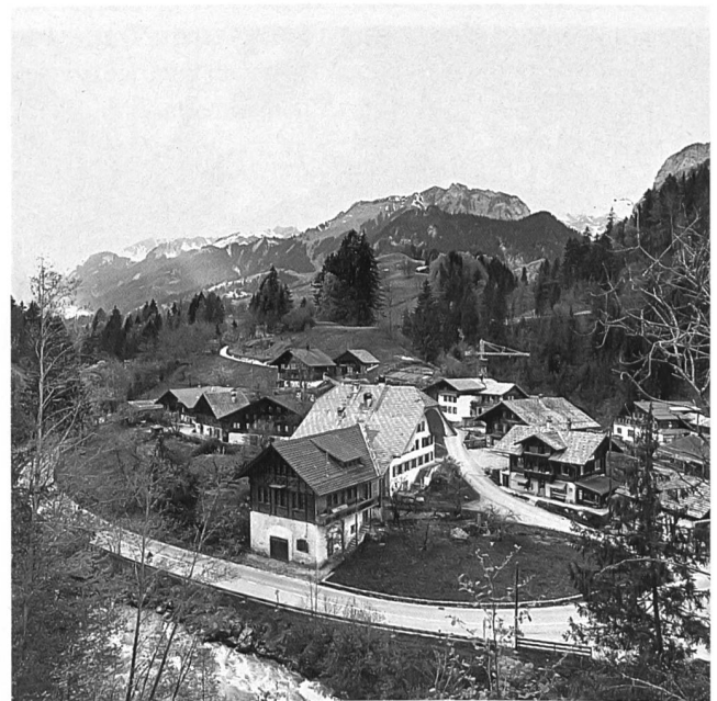
Abb.95: Därstetten, Ruine Weissenburg. Übersicht von Südosten mit Simme, Dorf und Burgplateau.
