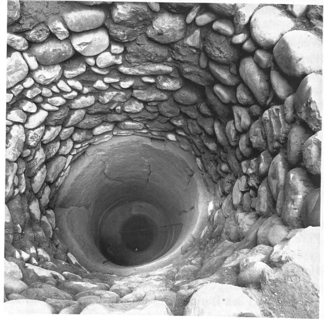
Abb.108: Detail des Sodbrunnens von Abb.107. Unterer Bereich direkt aus dem Felsen gehauen.
