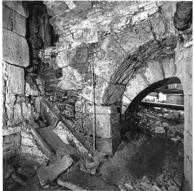
Abb.65: Bern, Postgasse. Unterführungsgewölbe des Stadtbachs. Ansicht von Norden.
