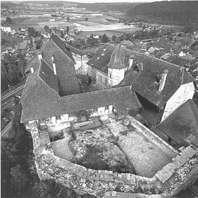
Abb.103: Laupen, Schloss. Die Gesamtaufnahme von Osten zeigt die elliptische Grundform der von dicken Ringmauern geschützten Hauptburg. Im Vordergrund die Ostbastion während der Grabung 1983.
