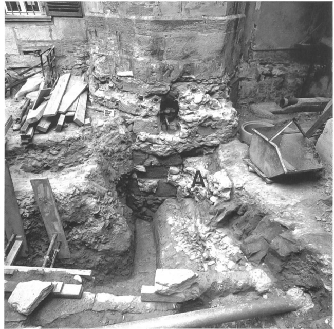
Abb.104: Laupen, Schloss. Der Treppenturm des «Neuen Schlosses» gründet im Burgraben der Kernburg. A Wehrmauer am östlichen Grabenrand.
