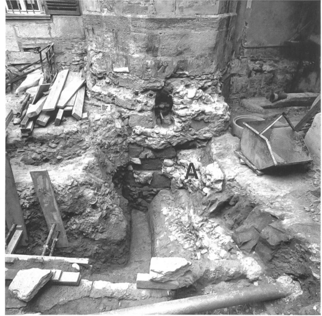
Abb.104: Laupen, Schloss. Der Treppenturm des «Neuen Schlosses» gründet im Burgraben der Kernburg. A Wehrmauer am östlichen Grabenrand.
