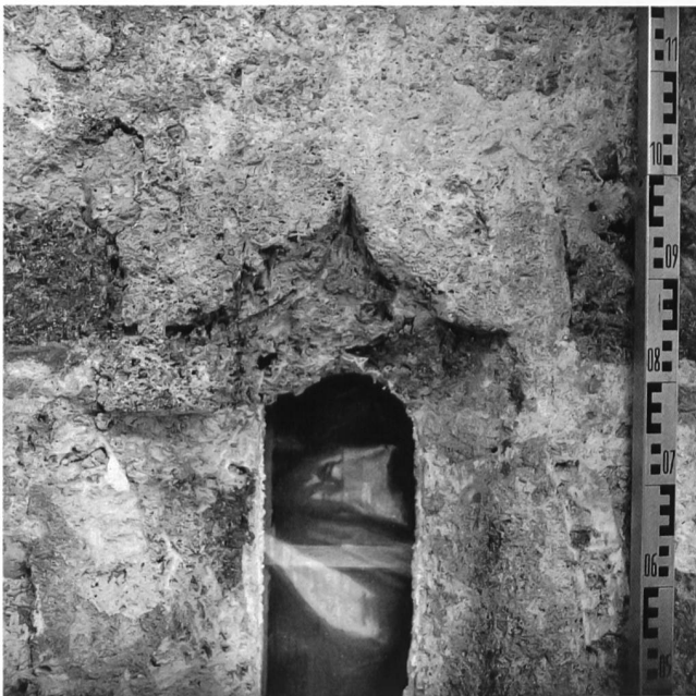
Abb.93: Blauen, Pfarrkirche St.Martin. Befund Turmfenster.
