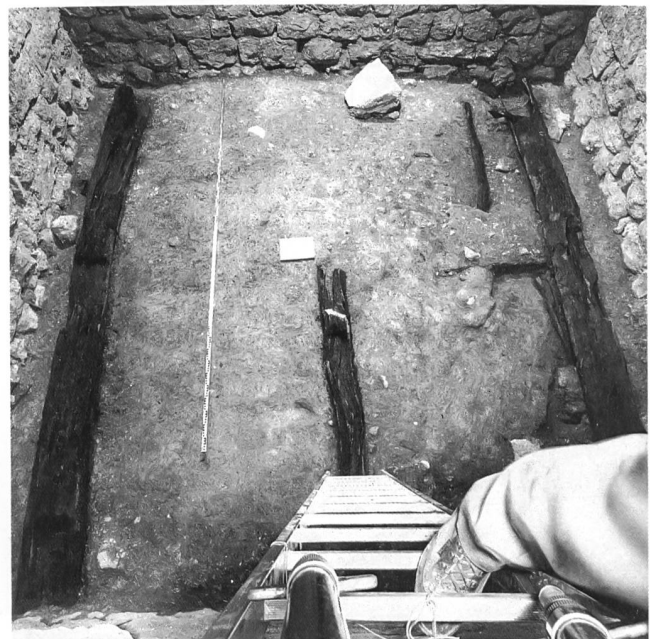
Abb.114: Nidau, Schloss. Übersicht der erhaltenen Eichenschwellen des Holzturmes.
