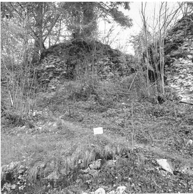
Abb.97: Därstetten, Ruine Weissenburg. Donjon vor der Sanierung.
