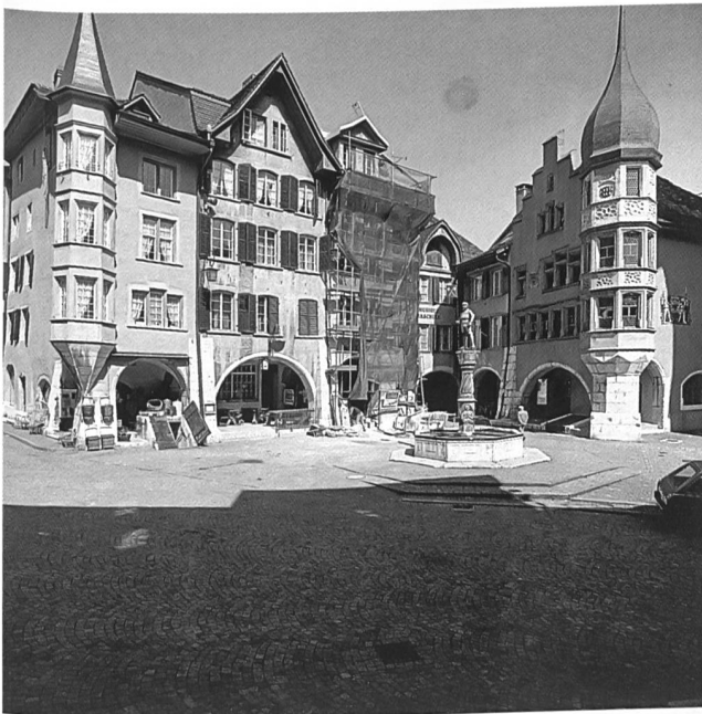
Abb. 86: Biel, Ring, Übersicht von Nordwesten, im Gerüst Ring 14.
