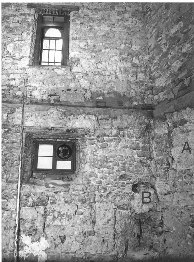
Abb. 85: Biel, Burggasse 27. Mittlerer Nordturm der Burg, Inneres nach Norden. A Palaswand, B Rundturmansatz.
