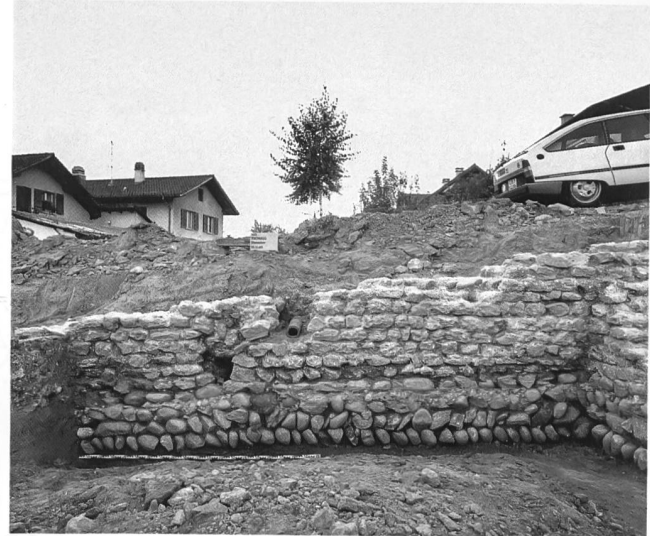
Abb. 4: Tschugg-Steiachler 1985. Raum A: Westmauer M2 mit Durchbruch einer alten Wasserleitung und Störung einer modernen Drainage.
