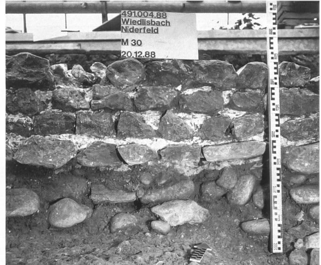
Abb. 12: Wiedlisbach-Niderfeld 1988/89. Mauer M30, Süd-Front. Man erkennt an der N-Mauer des Annexbaus 20 vier Lagen gemauertes Fundament, darunter die Rollierung. An dieser Stelle war das Fundament am besten erhalten. Ansicht nach Norden.
