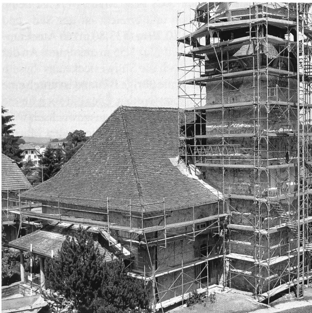
Abb.1: Das Äussere der Pfarrkirche von Südwesten während der Untersuchungen.
