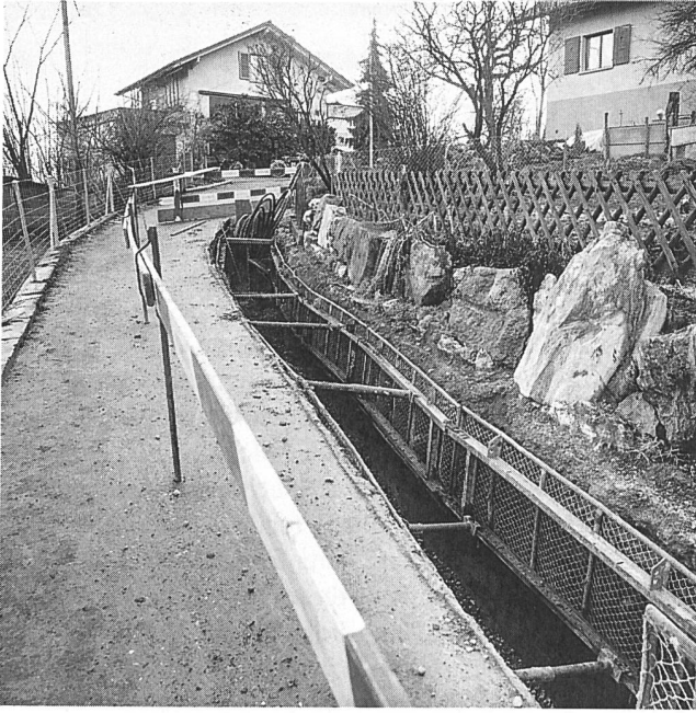
Abb. 2: Studen-Rebenweg 1987. Leitungsgraben. Blick nach Süden.
