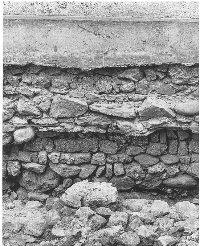
Abb. 5: Südmauer des Schiffes. Das älteste mittelalterliche Fundament (6); darüber das Fundament (7) der romanischen Kirche.
