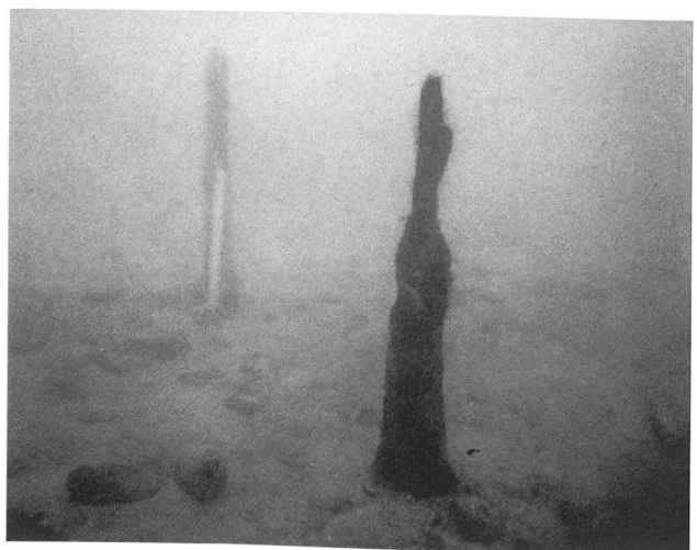
Abb. 4: Sutz-Lattringen - Sutz Südwest Va 1988/89. Spitz erodierte Pfahlköpfe.
