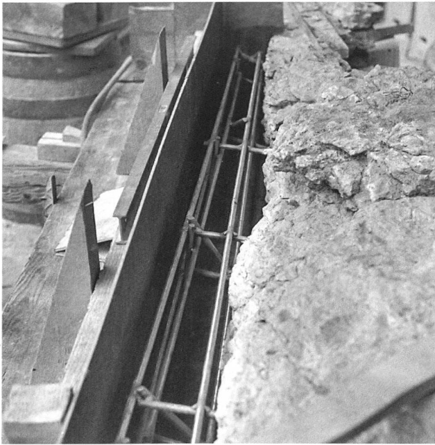
Abb. 18: Laufen - Dolmengrab. Restaurierung 1990/91. Südplatte (11) ... die zu einer Armierungskonstruktion verbunden und ...
