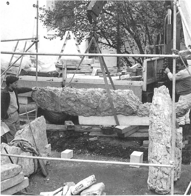
Abb. 21: Laufen - Dolmengrab. Wiederaufstellung 1991. Die West- und die Ostplatte stehen bereits. Jetzt wird die Südplatte mit dem Kran in die richtige Lage gebracht.
