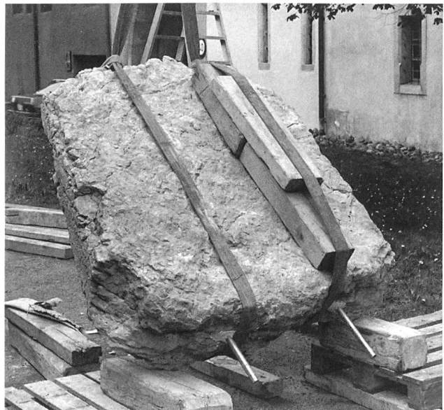
Abb. 20: Laufen - Dolmengrab. Wiederaufstellung 1991. Die mit Chromnickelstahl-Stäben versehene Westplatte wird in die dafür vorgesehenen Bohrlöcher im Magerbeton-Untergrund eingesetzt.
