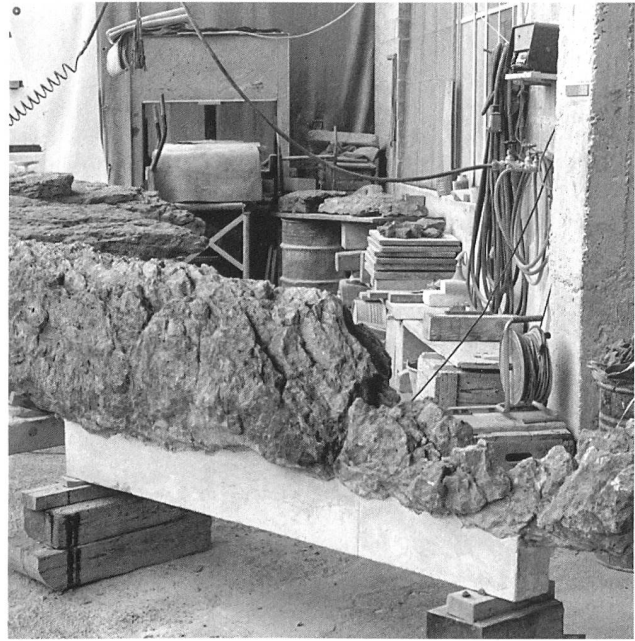
Abb. 19: Laufen - Dolmengrab. Restaurierung 1990/91. Südplatte (11). ... mit einem Kunststein-Fuss umgeben worden sind. Aufgrund ihrer Form erhielt die Platte den Namen «weisser Hai».
