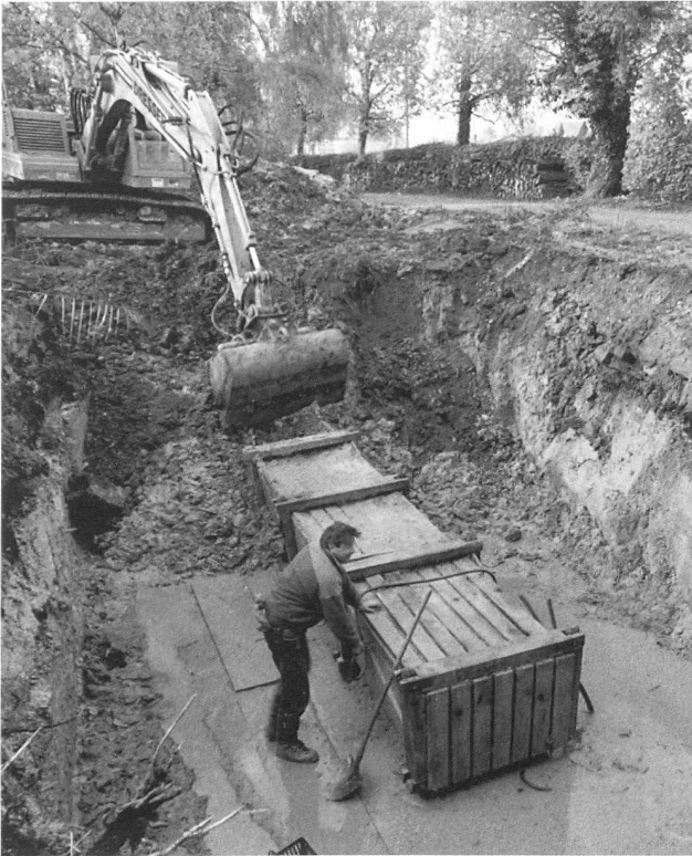
Abb. 11: Erlach - Heidenweg 1992. Wiederausgraben und Verladen des Einbaumes im Herbst 1993. Die Holzkiste mit dem Einbaum wird mit dem Bagger freigelegt; dazu saugen Pumpen das Grundwasser in der Grube ab.
