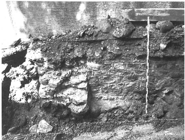
Abb. 19: Bern-Bümpliz - Mauritiuskirche 1969. Umbruch der Mauer nach Osten. Der Mauerwinkel ist im Verband aufgebaut. Blick nach Westen.
