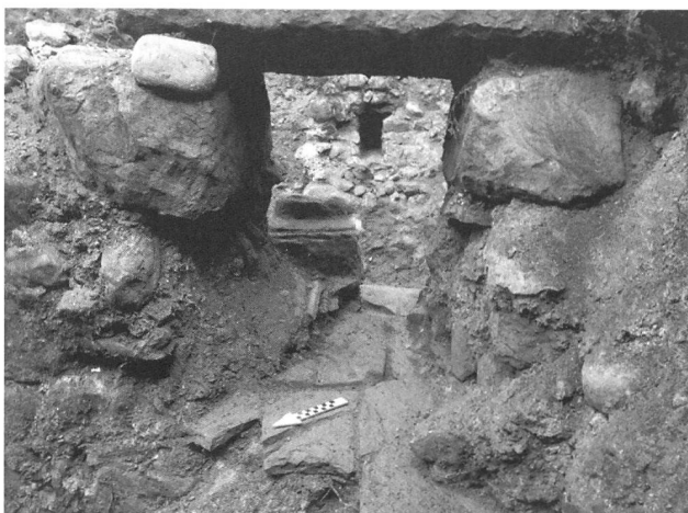
Abb. 12: Bern-Bümpliz - Mauritiuskirche 1968. Im Vordergrund Durchlass des Wasserkanals durch Mauer a. Im Hintergrund kleinerer gemauerter Abwasserkanal. Blick nach Osten.
