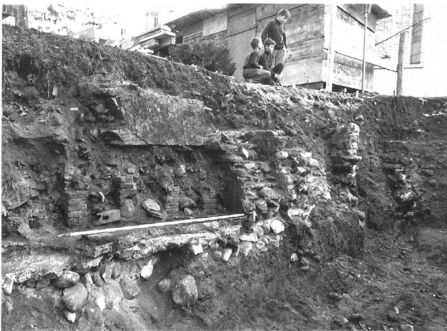
Abb. 15: Bern-Bümpliz - Mauritiuskirche. Raum A, östliche Baugrubenwand. Hypokaustpfeiler mit darüberliegender Mauer in Leichtbauweise. Im Hintergrund Südmauer des Raumes A und die südlich davon verlaufende Gangmauer. Am rechten Bildrand der kleine, gemauerte Abwasserkanal. Blick nach Südosten.
