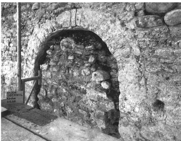
Abb. 5: Der Bogen (104) des Einganges an der Nordwestecke.
