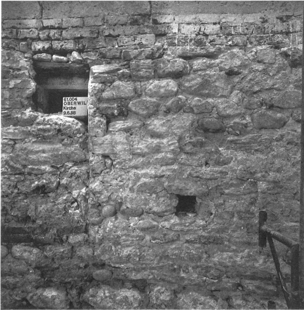
Abb. 4: Mauerwerk (103) der Reparatur nach der Zerstörung der Anlage IV durch Brand.
