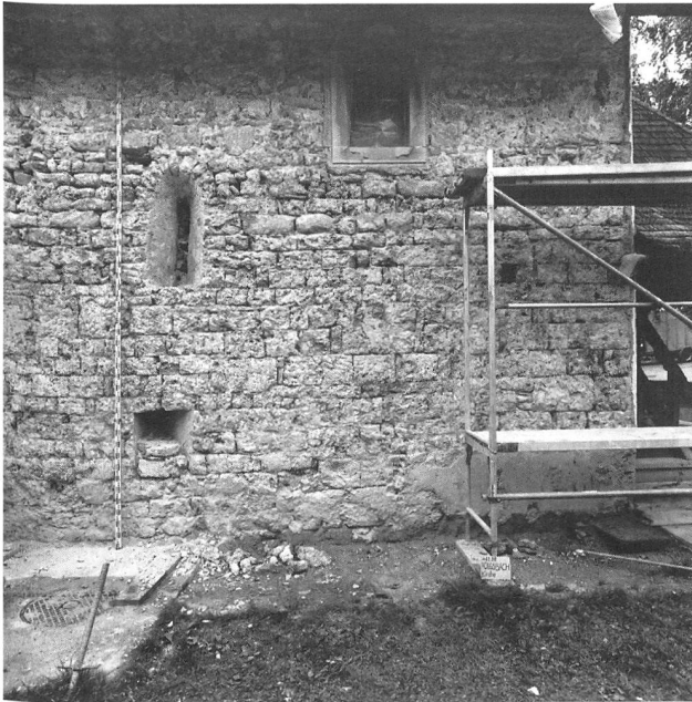
Abb. 4: Die Nordfassade des Schiffes mit romanischem Mauerwerk.
