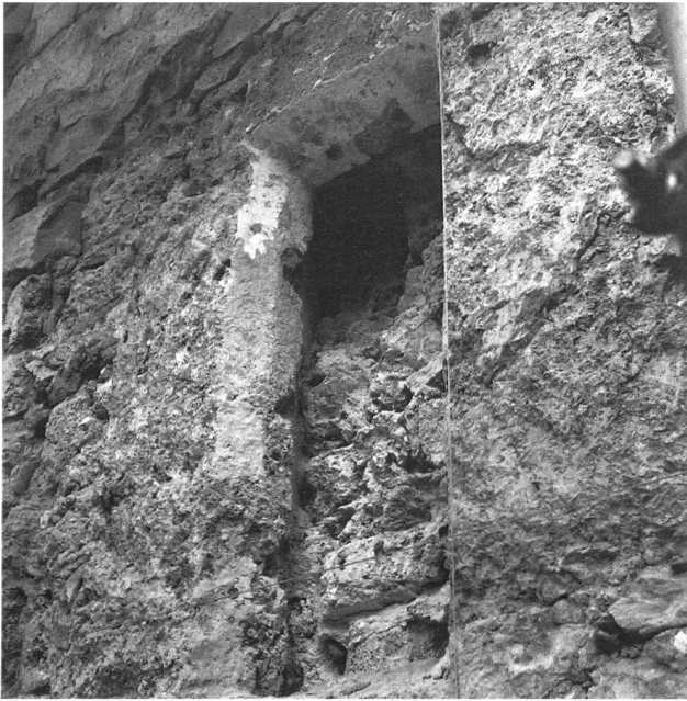
Abb. 6: Das spätmittelalterliche Fenster in der Südmauer des Schiffes.
