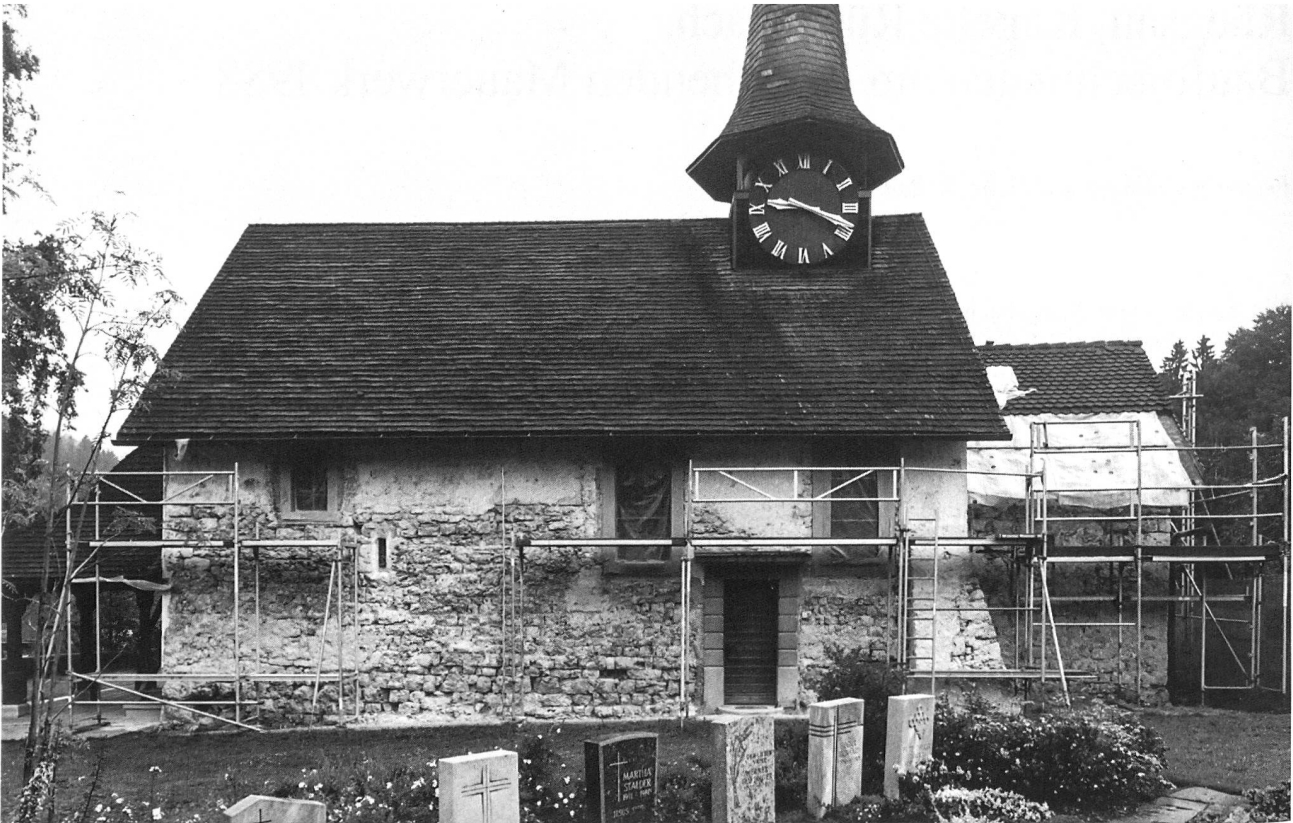
Abb. 2: Südseite der Kapelle während unseren Untersuchungen 1988.
