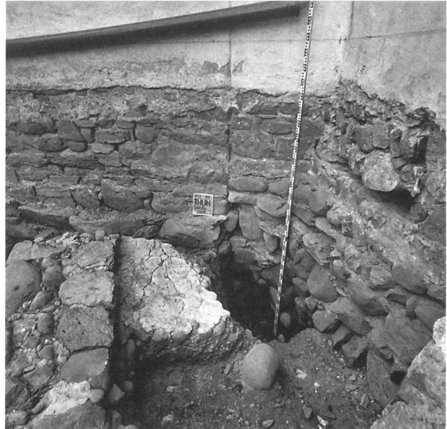
Abb. 25: Detailansicht an Turmostseite, Chorschulter und Apsisansatz mit vermauertem Türdurchlass.
