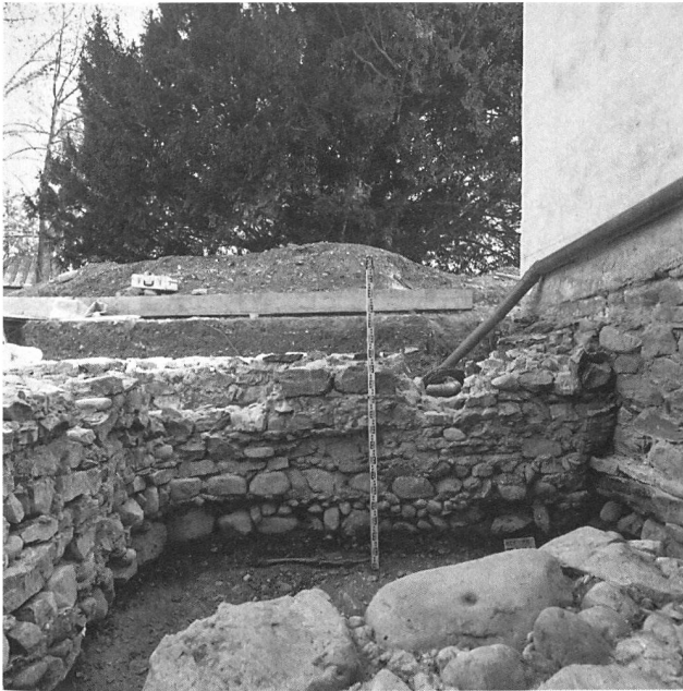
Abb. 33: Blick nach Süden an das Fundament der Sakristei I.
