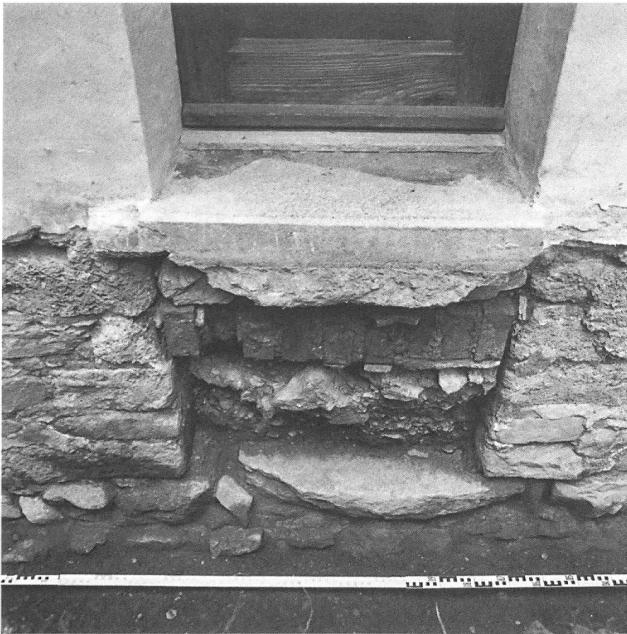
Abb. 31: Ursprünglicher Südzugang zum Schiff mit erhaltener Schwelle.
