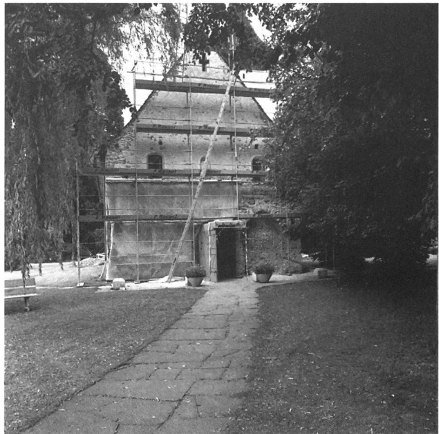
Abb. 43: Übersicht der vom Verputz befreiten Westwand.
