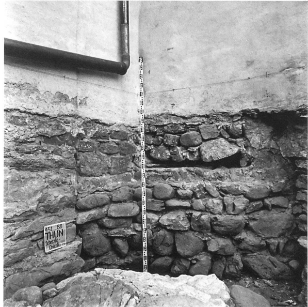
Abb. 29: Ansicht von Süden ans Apsisfundament (12) mit Türdurchlass (18) in verschiedenen Zuständen.
