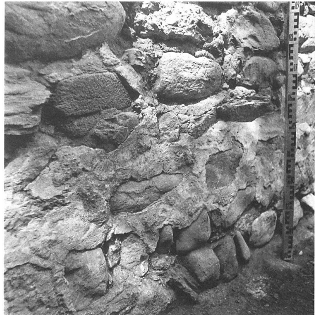
Abb. 32: Mauercharakter der Schiffsmauern (14) mit originalem Pietrasarsa-Verputz.
