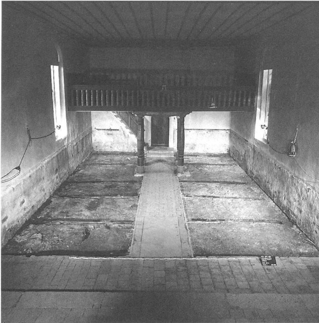
Abb. 3: Gampelen, Kirche. Blick im Schiff nach W mit den freigelegten Balkenlagern des Bodens von 1675.
