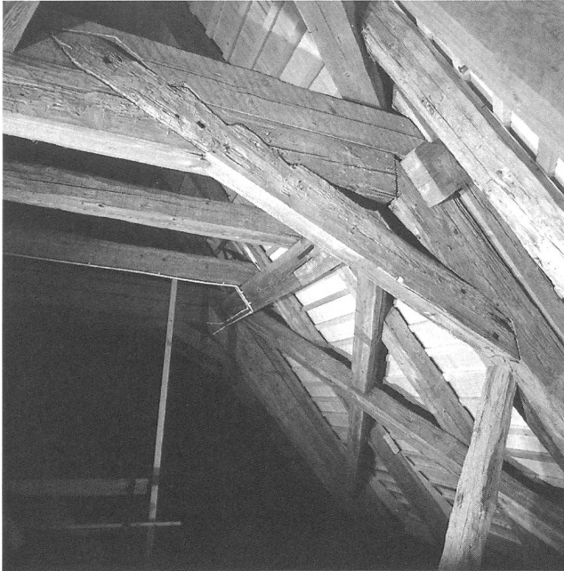
Abb. 15: Kopfhölz eines wiederverwendeten Gebindes aus dem 16. Jahrhundert.
