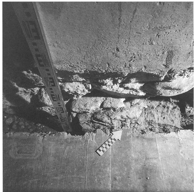
Abb. 11: Detail Nordwestecke von Anlage I.
