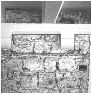
Abb. 25: Die Konsolen und Streifbalken (64) in Raum 2 von Postgasse 70, Blick gegen Osten.
