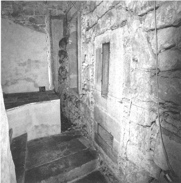
Abb. 7: Schrägansicht der Südmauer von aussen gegen Westen. Gut zu erkennen ist das Gewände der Türe (321).
