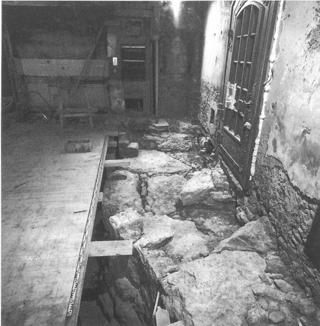
Abb. 2: Ansicht des Fundamentes des Rundturmes der Burg Biel, 1985. Blick nach Westen.
