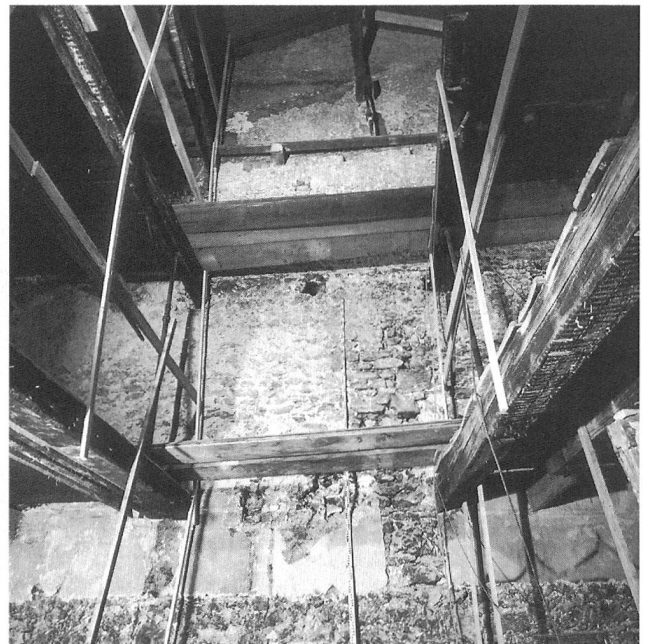
Abb. 9: Biel, Obergässli 5. Westmauer (12) im 1. und 2. Obergeschoss, Blick nach Westen.
