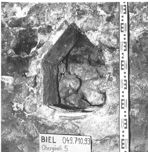
Abb. 11: Biel, Obergässli 5. Lichtnische (37) im Erdgeschoss von Westmauer (12), Blick nach Westen.
