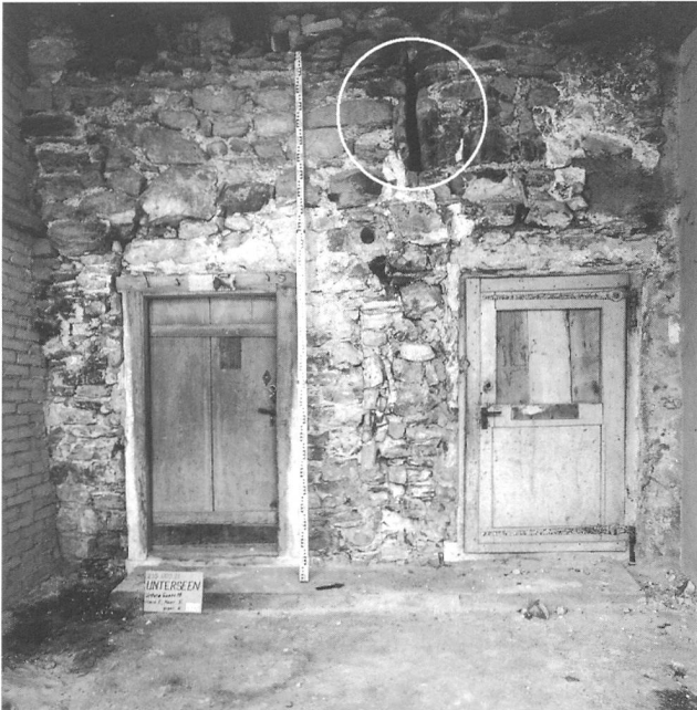
Abb. 3: Unterseen, Under de Hüsere 18. Stadtmauer (1) mit Scharfenfenster (2). Blick nach Westen.
