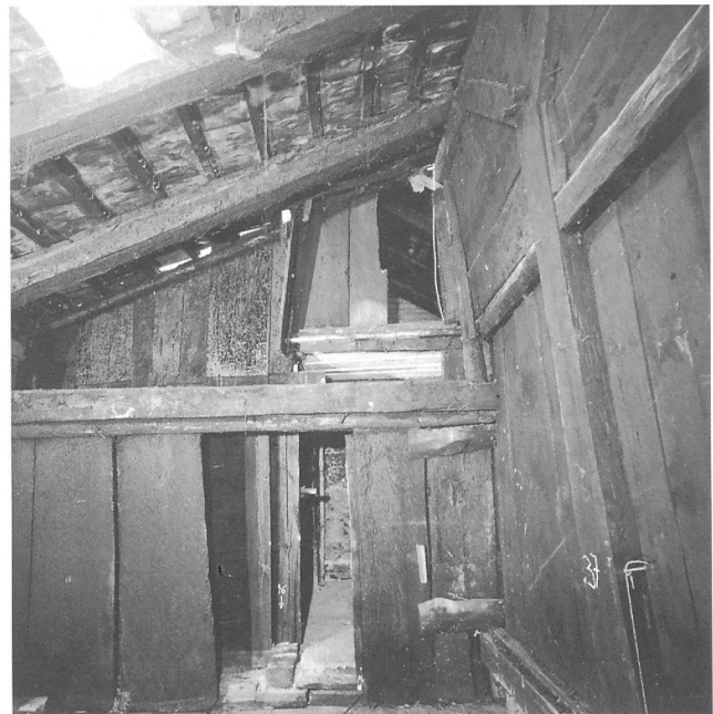
Abb. 13: Unterseen, Under de Hüsere 18. Zweiter Umbau des Kernbaus, Dachgeschoss, Bundbalken (59), Kehlbalcken (60) und Bohlenwand (55). Blick nach Süden (vgl. Abb. 10).
