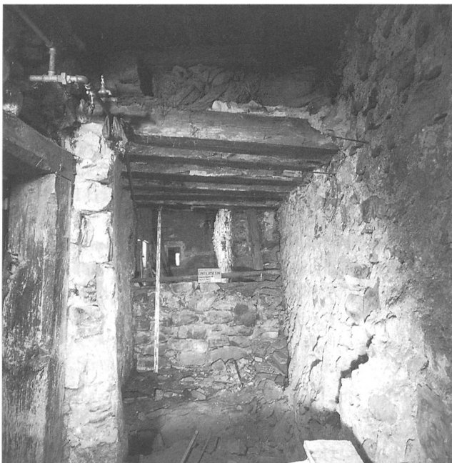
Abb. 17: Unterseen, Untere Gasse 19. Kellerraum mit Deckenbalken (159), Nordmauer (160) und Südmauer (158), Übersicht nach Osten.
