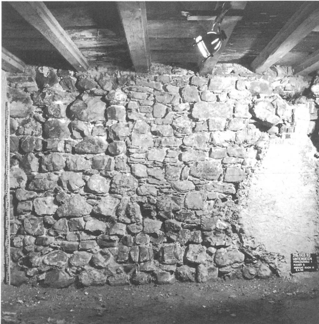
Abb. 7: Südmauer (3) im Keller Müligasse 1. Blick nach Norden.
