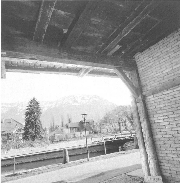
Abb. 14: Unterseen, Under de Hüsere 18. Erweiterung des Kernbaus nach Osten, Fassadenständer (61), Schwelle (62) und Decke des ersten Wohngeschosses (vgl. Abb. 10).
