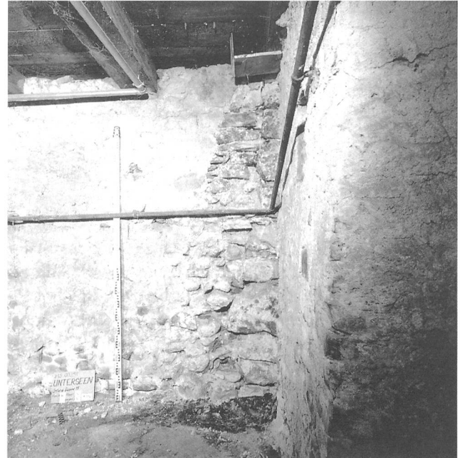
Abb. 4: Unterseen, Untere Gasse 19. Westliche Mauerecke (193) des nördlichen Nachbarhauses. Blick nach Norden mit Eckverband.
