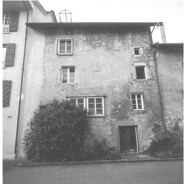
Abb. 23: Die Nordfassade von Städtli 30/34 bildet die Stadtmauer.
