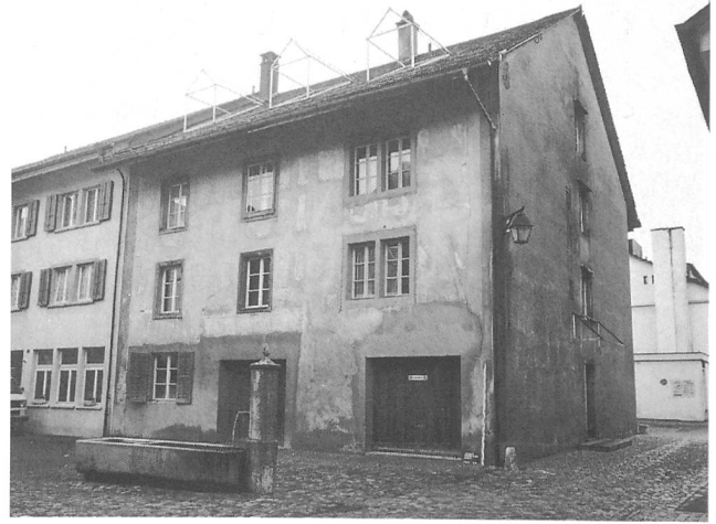
Abb. 13: Wangen, Städtli 60. Ansicht des Hauses vor seinem Abbruch (Aufnahme vom 13.12.1993). Blick gegen Südosten.
