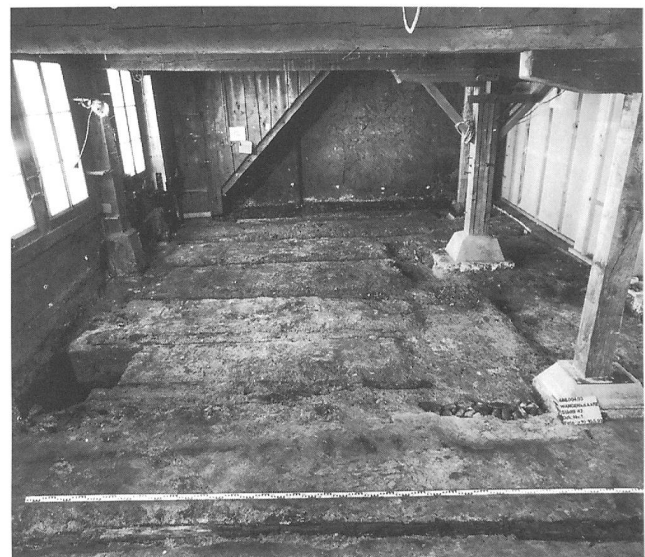
Abb. 11: Wangen, Städtli 42. Die Balkenlager (5) und (22) zum Boden der jüngsten Phase. Blick gegen Norden.
