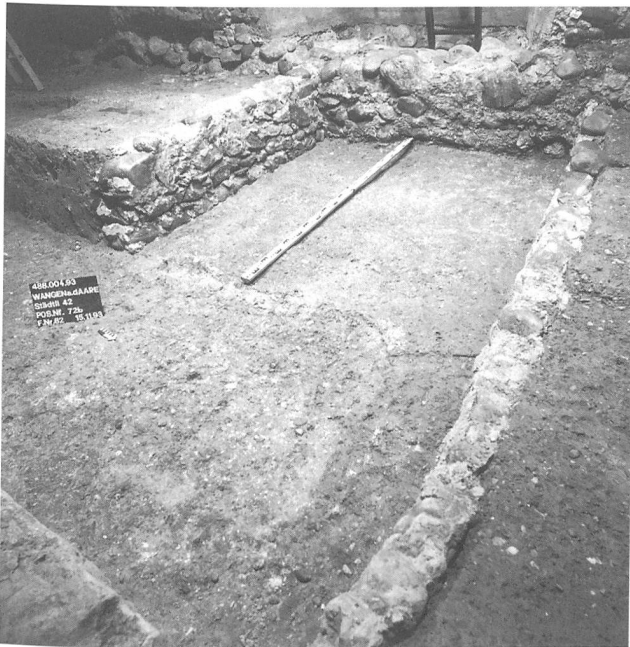
Abb. 7: Wangen, Städtli 42. Der halb eingetiefte Keller (72) aus Phase 2. Blick gegen Nordosten.
