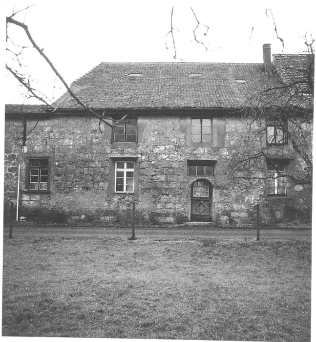
Abb. 5: Die Westfassade von Städtli 42 besteht grösstenteils noch aus der mittelalterlichen Stadtmauer. Blick gegen Osten.
