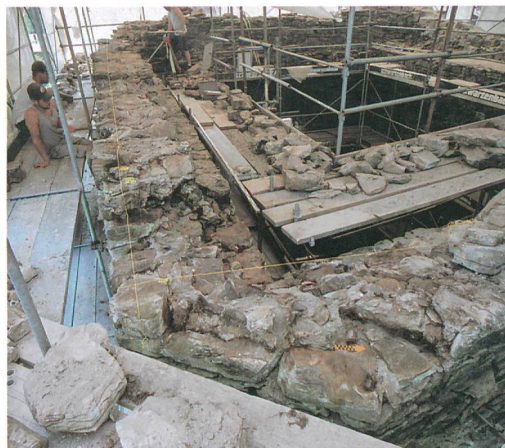
Abb. 12: Ringgenberg, Burgruine. Sanierung der Mauerkrone des Bergfrieds.
