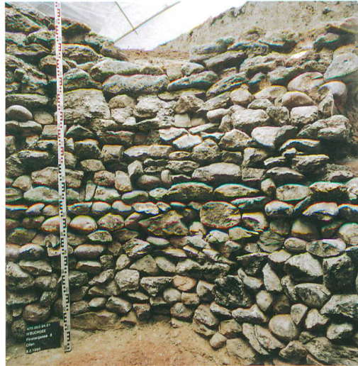
Abb. 6: Herzogenbuchsee, Finstergasse 8. Die in Trockenmauertechnik gefügte Wand (27) des Kalkbrennofens. Blick nach Nordwesten.
