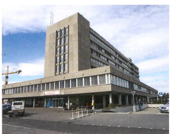
Tiefgarage am Schermenweg
