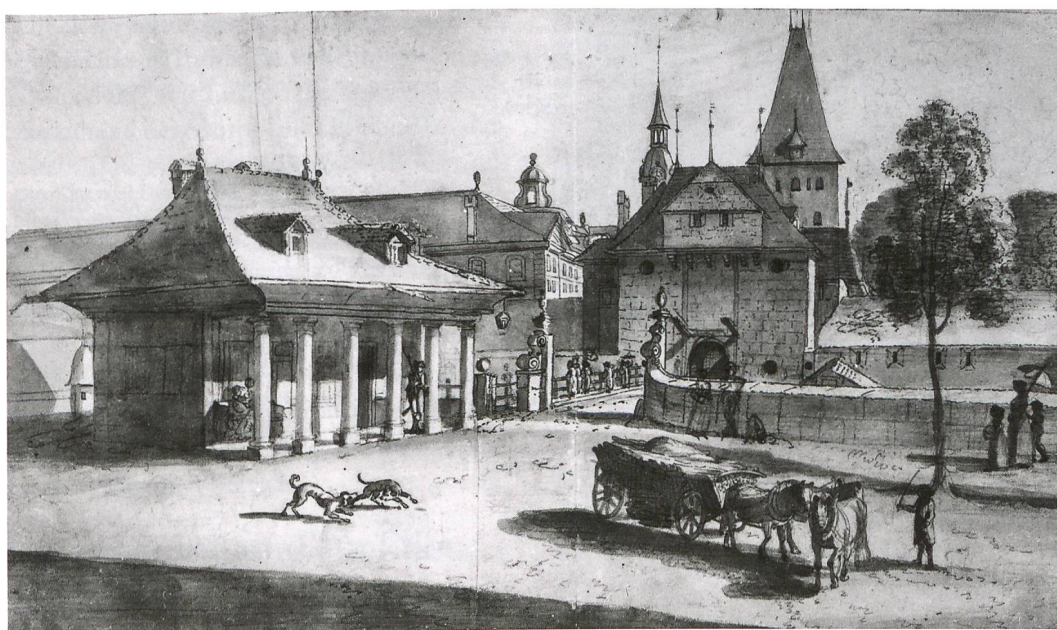
Abb. 37: Das Äussere Obertor von aussen. Ansicht Sigmund Wagners aus dem Jahr 1807. Der Haupttorbau könnte bereits abgebrochen sein; sein hohes Walmdach müsste auf der Zeichnung eigentlich zu sehen sein.
