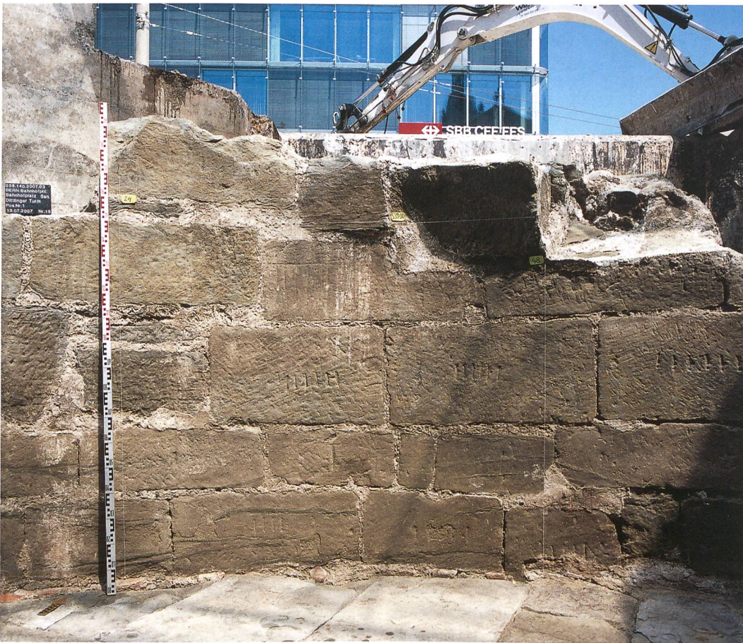
Abb. 25: Bern, Bahnhofplatz. Steinbehau und Schichthöhenzeichen im Dittlinger-Turm.
