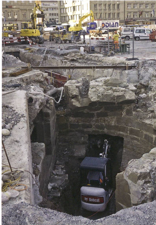
Abb. 26: Bern, Bahnhofplatz. Einbau der Hochspannungslleitung durch den Turm.
