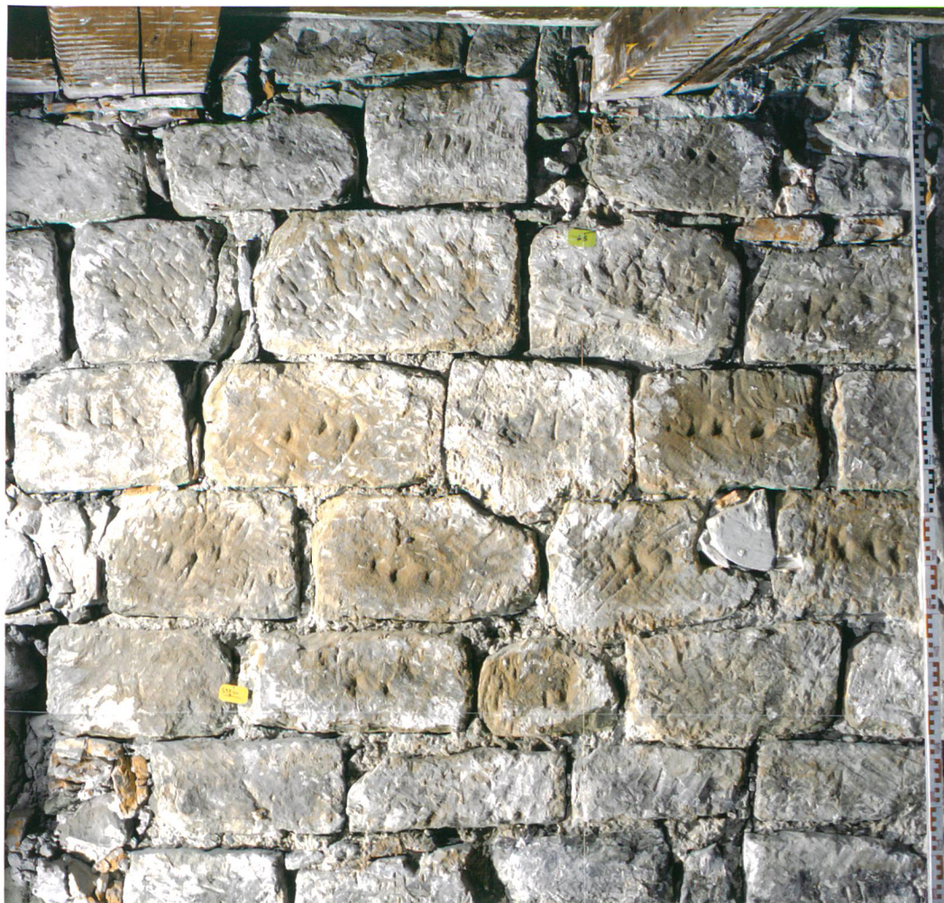
Abb. 3: Bern Gerechtigkeitsgasse 7, «Goldener Adler». Detail des Mauerwerks der Phase 2: Sandsteinquader mit Schichthöhenzeichen aus dem 14. Jahrhundert.
