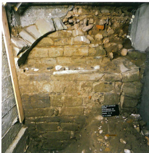
Abb. 4: Bern, Kramgasse 36. Kellermauer mit Wandnische, später zugemauert. Im Vordergrund ist die Füllung sichtbar, mit der der Keller bei seiner Auflassung zugeschüttet wurde.
