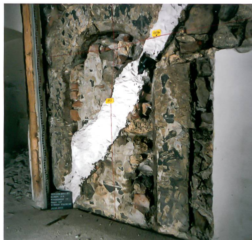
Abb. 7: Büren a. A., Kreuzgasse 20. Eines der Rundbogenportale des Steinhauses der Phase blau.
