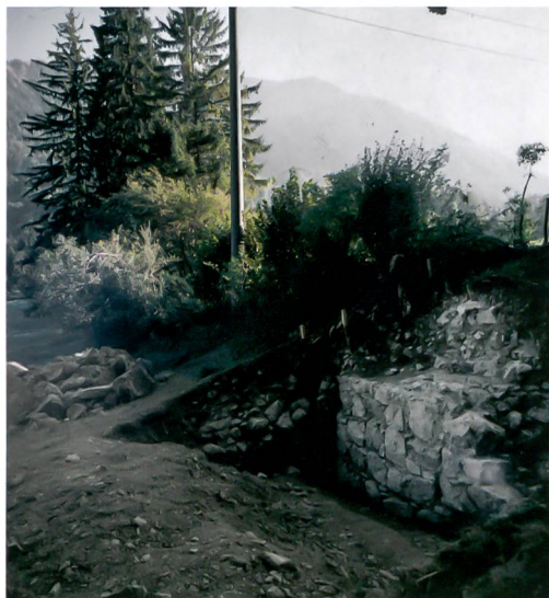
Abb. 3: Wimmis, Spissi. Die Grabungssituation vor dem Anlegen des Profilschnittes 1. Die Landmauer ist unter einem stark bewachsenen Schutthügel verborgen. Rechts im Bild die talseitige Mauerschale mit dem angeschnittenen Schutthügel. Blick von Norden.
