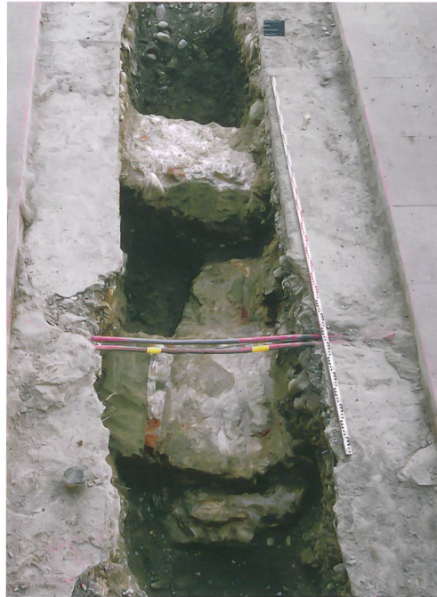
Abb. 3: Bern, Kochergasse. Blick nach Norden in den Leitungsgraben mit den zwei parallel liegenden Fundamenten.
