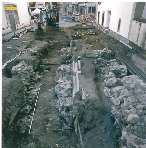
Abb. 4: Unterseen, Untere Gasse. Freigelegte Mauerzüge im Bereich des ehemaligen Thomattinentors und des zugehörigen Stadtgrabens. Blick nach Norden.
