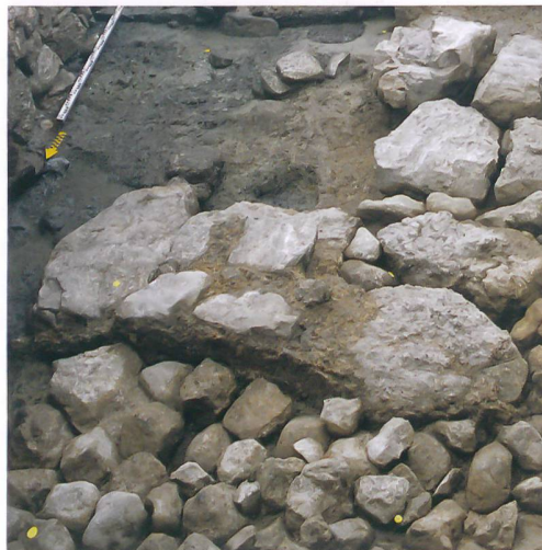
Fig. 19: Moutier, Rue Centrale 57. Enduit de mortier recouvrant la paroi nord du mur 95, mis au jour en 2012 dans la cave de l'ancien Hôtel du Cerf.
