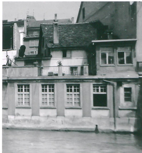
Abb. 7: Thun, Bälliz 30. Der fünfschichtige eingeschossige Saal gehörte zur Gastwirtschaft «Zum Kanonier». Er entstand 1926 und reichte bis zum Aareufer. Dahinter ist der hohe Kernbau erkennbar, der zwischen 1885 und 1909 durch die Aufstockung der alten Bausubstanz entstand. Zustand 1972. Blick nach Osten.
