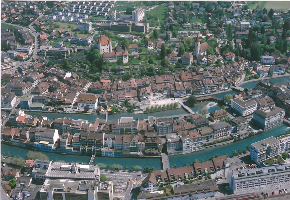
Abb. 2: Thun, Flugaufnahme 2001 mit Blick nach Norden. Sichtbar ist im Hintergrund der Schlossberg, der westseitig vom Schloss, ostseitig von der Stadtkirche begrenzt wird. Zu seinen Füßen liegt die Gründungsstadt und westlich anschliessend die Alte Neuenstadt. Davor ist die Innere Aare erkennbar, vor der sich südseitig die langgezogene Bälliz-Insel und die Äussere Aare erstrecken.
