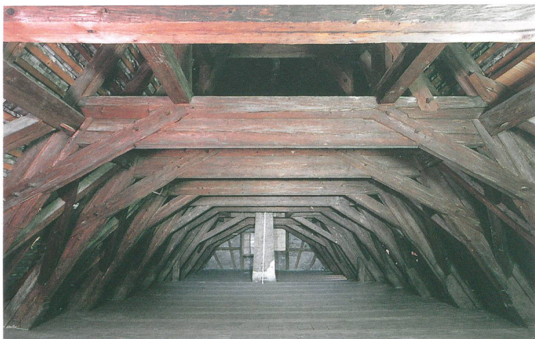
Abb. 6: Thun, Schloss. Mittlerer Abschnitt des südlichen Schlosstrakts, liegender Dachstuhl des Kernbaus von 1566/67. Blick nach Nordwesten.
