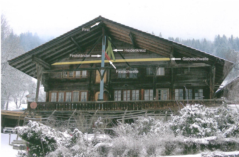
Abb. 18: Erlenbach, Ringoldingen, Heidenhaus. Südfassade mit Heidenkreuz und Ständersystem. Blick nach Norden.
