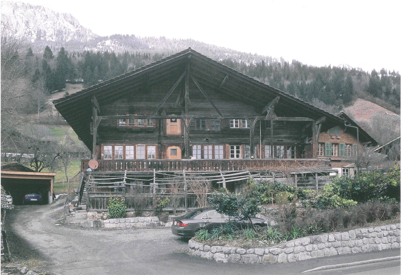
Abb. 3: Erlenbach, Ringoldingen, Heidenhaus. Südfassade. Das Haus ist heute entlang der Fistlinie zweigeteilt. Gut erkennbar ist die durch die zusätzliche Stube im Osten entstandene Asymmetrie des Gebäudes. Blick nach Norden.
