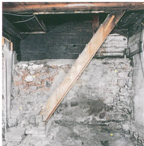
Abb. 30: Erlenbach, Ringoldingen, Heidenhaus. Küche. In der Nordostecke der Küche zeigte sich ein ungewöhnlicher Eckverband. Die Ostmauer wurde in Bauphase IV durch eine Backsteinmauer ersetzt. Blick nach Norden.
