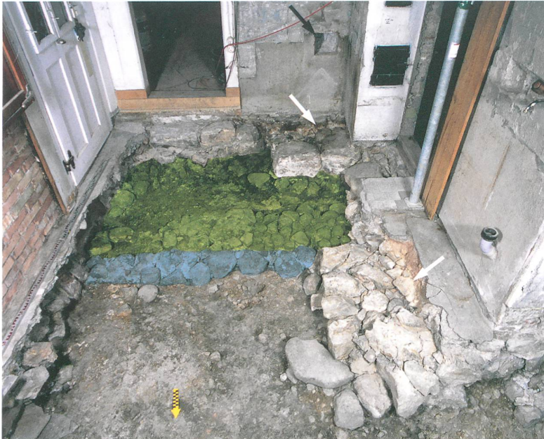
Abb. 24: Erlenbach, Ringoldingen, Heidenhaus. Blick in den offenen Küchenraum. Weisse Pfeile: die beiden möglichen Ofenfundamente; schwarzer Pfeil: Schüröffnung des Stubenofens; grün: Geröllsteinpflasterung im Quer-gang; blau: Streifenfundament von Kammer 2. Blick nach Süden.
