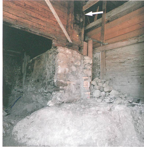
Abb. 31: Erlenbach, Ringoldingen, Heidenhaus. Links: Fortsatz der Ostmauer nach Norden. Auf der Mauer liegen die Schwelle und der Vorstoss der Ostwand. Blick nach Südosten. Rechts: Blick auf die Nord- und Ostmauer während der Umbauarbeiten im Sommer. Die Mauer steht auf dem Felsen. Nach Süden bildet sie eine Stirn oder einen Absatz, dahinter zeigt sich die Vormauerung. Blick nach Nordwesten.
