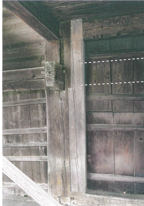
Abb. 16: Schwarzenburg, Junkerngasse 17. Sowohl der Stalleingang (links) als auch die alte Haustür (rechts) reichten ursprünglich nur bis zur Höhe der Bundbalken. Bei der Erhöhung des Hauseinganges um 1870 wurde der Balken (gestrichelt) entfernt. Der Türpfosten (hell markiert) des jetzigen Hauseinganges wurde in die alte Passstelle eingefügt. Blick nach Nordwesten.
