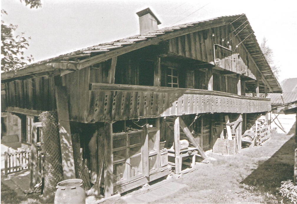
Abb. 25: Schwarzenburg, Junkerngasse 17, nordöstliche Fassade. Im Zuge des Umbaus von 1870 wurde der Wetterschild stark verkürzt. Die Giebel- laube stammt von einem älteren Haus und wurde gemeinsam mit den beiden Stuben eingebaut. Die verbretterte Fläche unter der linken Dach- traufe gehört zur 1870 entstandenen «Frucht- kiste». Rechts daneben der gleichzeitig einge- baute Gaden. Das Foto entstand 1993 und zeigt am rechten Bildrand den heute nicht mehr vorhan- denen Wagenschopf. Blick nach Nordwesten.
