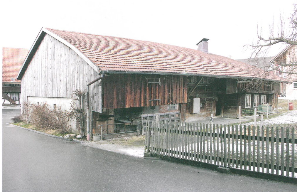
Abb. 26: Schwarzenburg, Junkerngasse 17. Blick auf die südliche Haus­hälfte mit dem südwestlichen Giebel, der 1891 mit einer verputzten Stall­mauer versehen wurde. Blick nach Norden.
