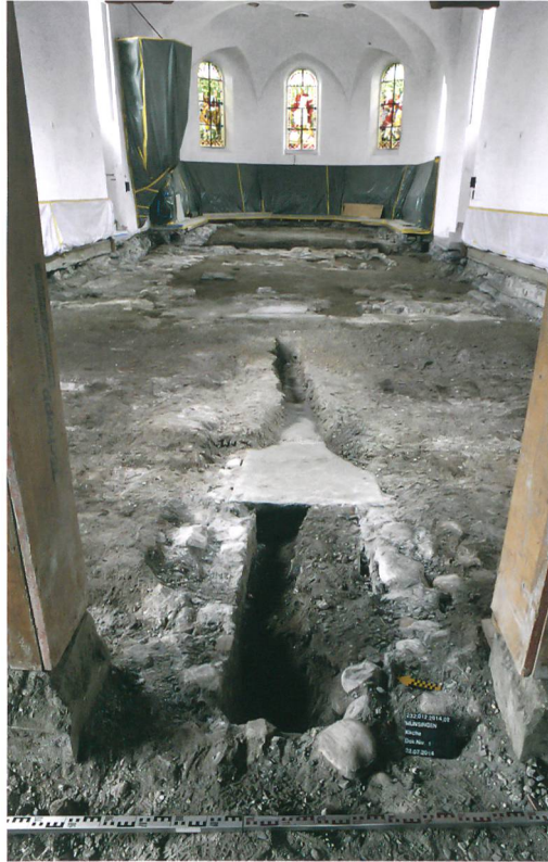
Abb. 6: Münsingen, Kirche. Der Kanal der Warmluftheizung von 1907. Blick nach Osten.
