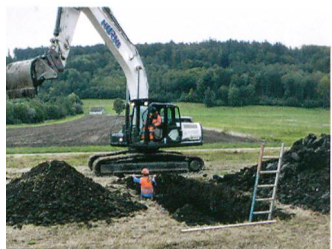
82 Port, Spärs, Wehrstrasse
