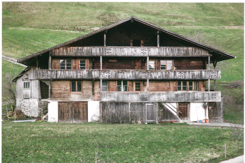
Abb. 2: Thun, Goldiwil, Matthausweg 23. Westliche Giebelfassade mit gemauertem Kellergeschoss, Blockbohlenständerbau im Stubengeschoss und Blockbau im Gaden- und Dachgeschoss. Küchen-, Gaden- und Bünislauben gehören konstruktiv zum Ursprungsbau, wurden aber nachträglich erneuert und verbreitert. Blick nach Osten.
